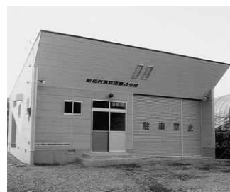
第四分団詰所を建設
