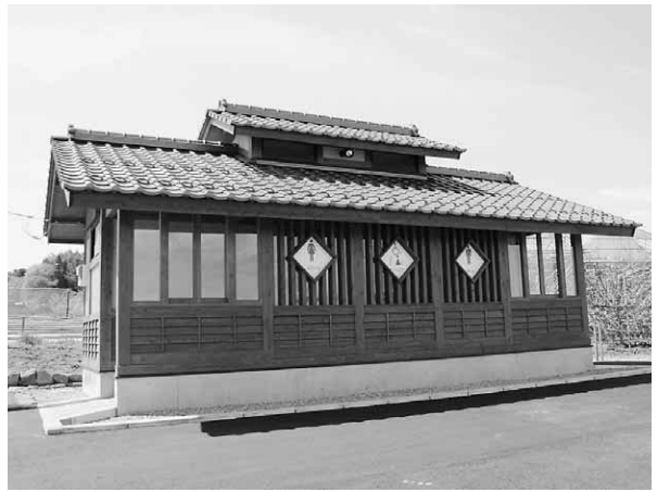
完成したトイレ
