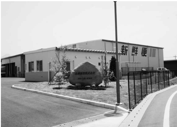
関屋工業団地に完成した佐藤運送(株)昭和インター営業所
