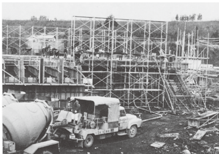
建設中の役場庁舎(昭和44年～45年)
