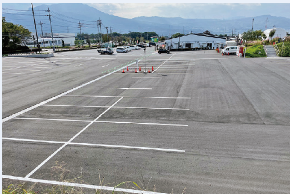
拡張された道の駅駐車場
