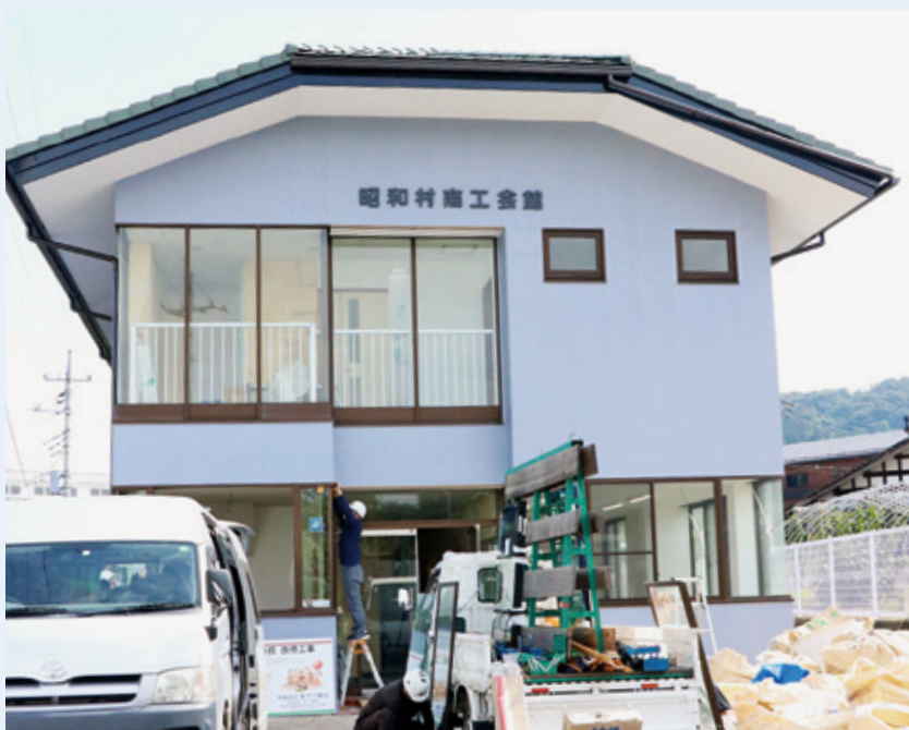
リフォームが進む商工会館
