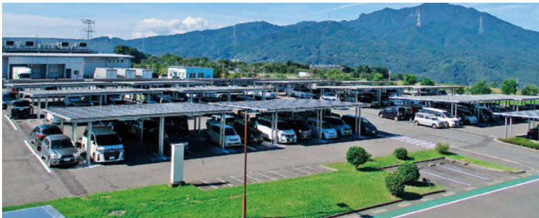
駐車場をカーポート化、屋根に太陽光パネル設置
