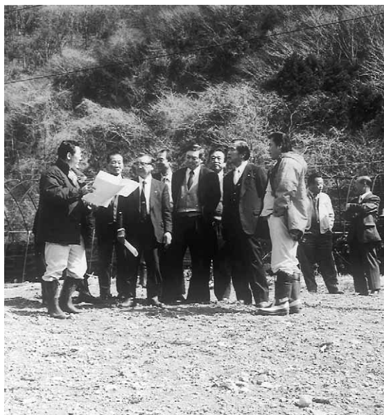
永井・入原地区農集排処理施設工事を調査
