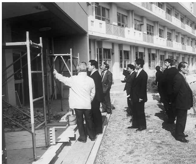
学童保育所工事を視察
