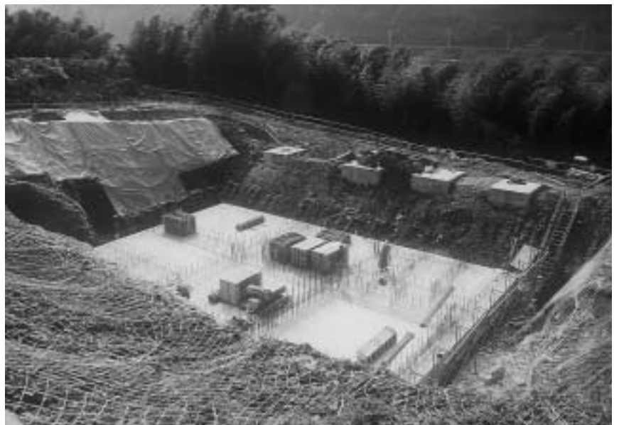
▲永井・入原地区污水处理施設建設地
