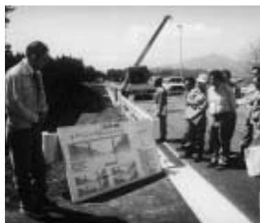
▲長者久保橋工事現場
