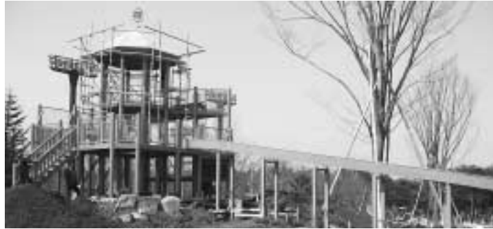
▲芝生公園建設中の展望舎・ローラー滑台
