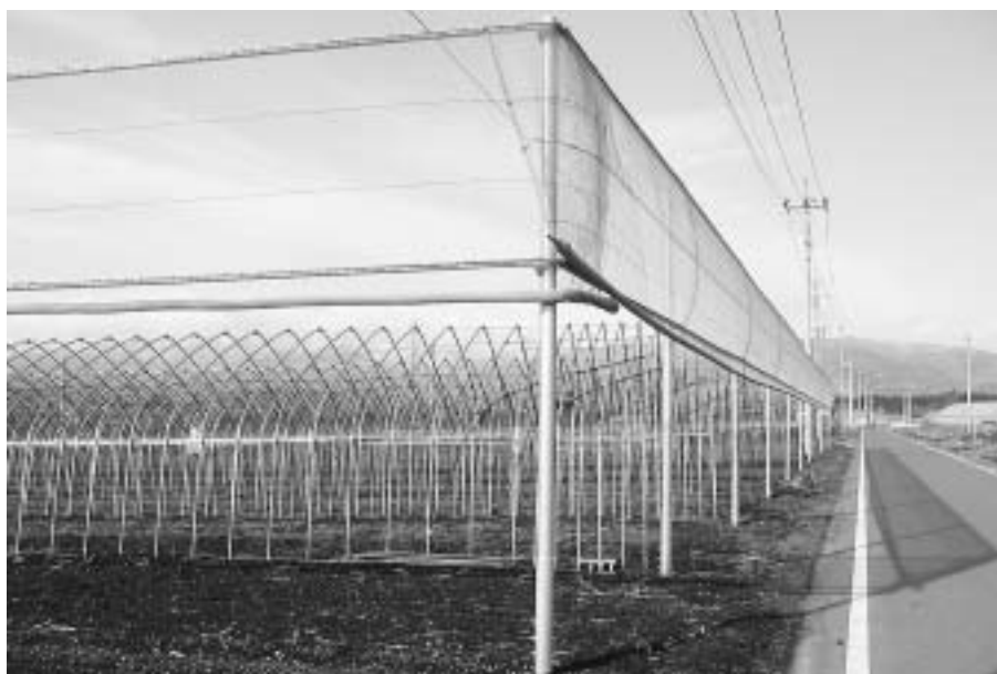
「夢」支援事業により設置された防風ネット
