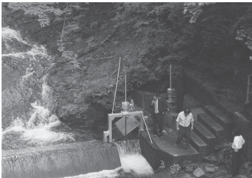
赤城北麓土地改良区第1水源地（鷹ノ巣川取水口）
