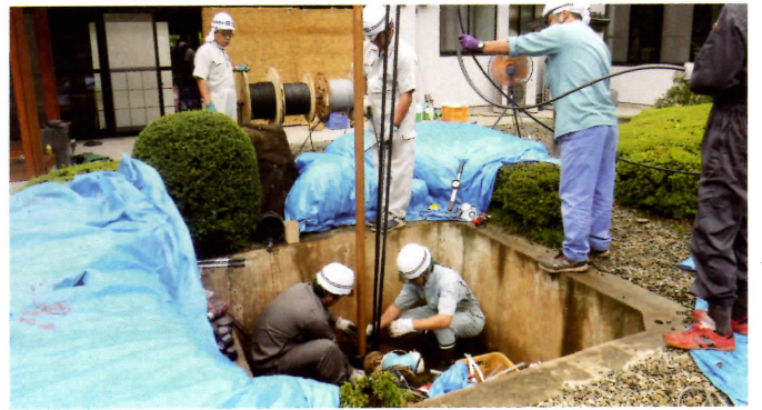
温泉ポンプ引き上げ工事
