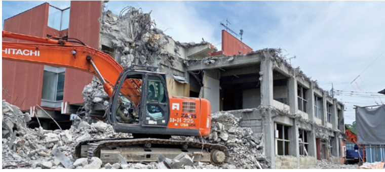
旧庁舎解体の様子
