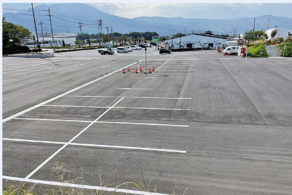
拡張された道の駅駐車場
