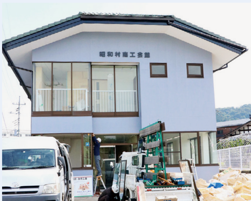
リフォームが進む商工会館
