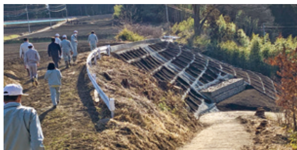
田岸地区土砂崩れ復旧現場
