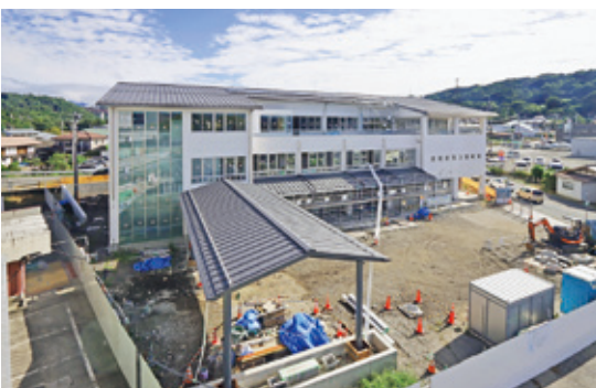
役場新庁舎建設工事 9月現在
