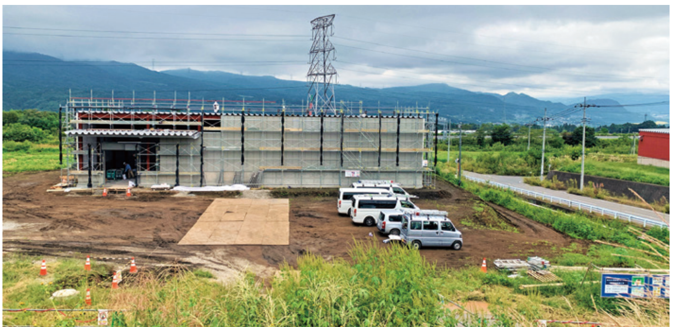
増築が進む工業団地
