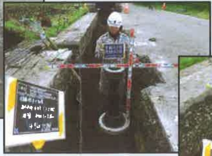
制水弁設置
