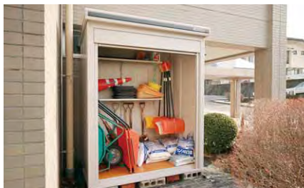
公民館玄関横に設置された倉庫
