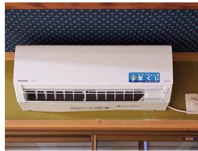
新たにエアコンを設置
