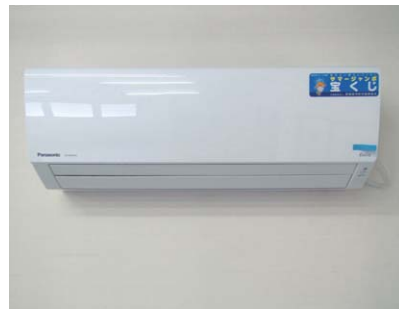
新たにエアコンを設置
