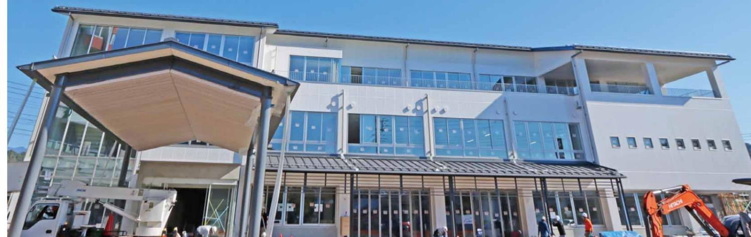
**利** 用しやすく親しまれる庁舎を目指し、令和3年度より始まった建設工事は順調に進み、基礎工事、鉄骨建て方工事を経て外壁・屋根工事まで終了しました。
