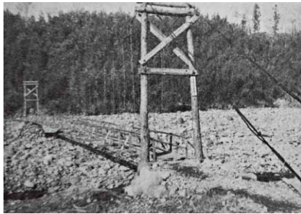
昭和23年の流失後は簡単な吊り橋となり20年利用された。昭和43年より永久橋となる。
