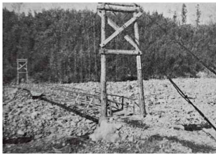
昭和23年の流失後は簡単な吊り橋となり20年利用された。昭和43年より永久橋となる。
