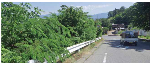
草木により視界を遮っている通学路（着工前）
