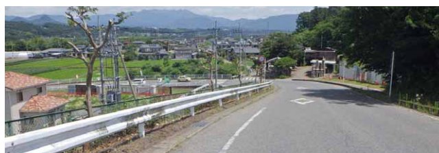
伐採により見通しが改善（着工後）
