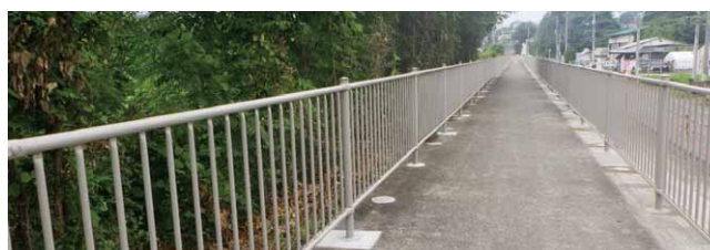
道にはみ出た草木がきれいに（着工後）
