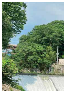
現在の万延橋と発電所の取水口付近
