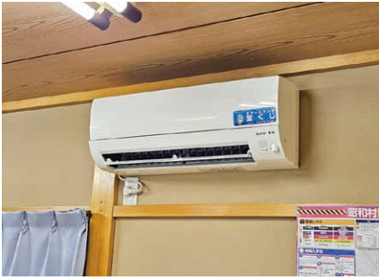
椋久保住民センターにエアコン整備
