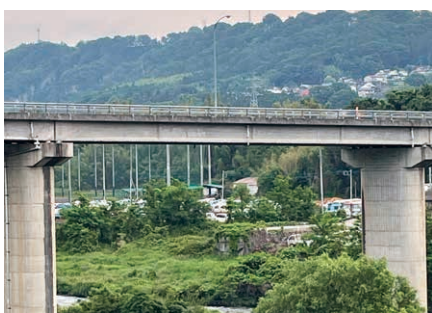
▲現在の君河原橋(写真2) (中央の石垣が以前の橋脚)
