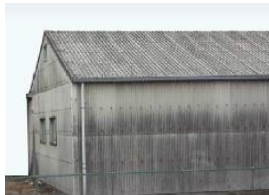
石綿含有スレート波板（屋根・外壁）
