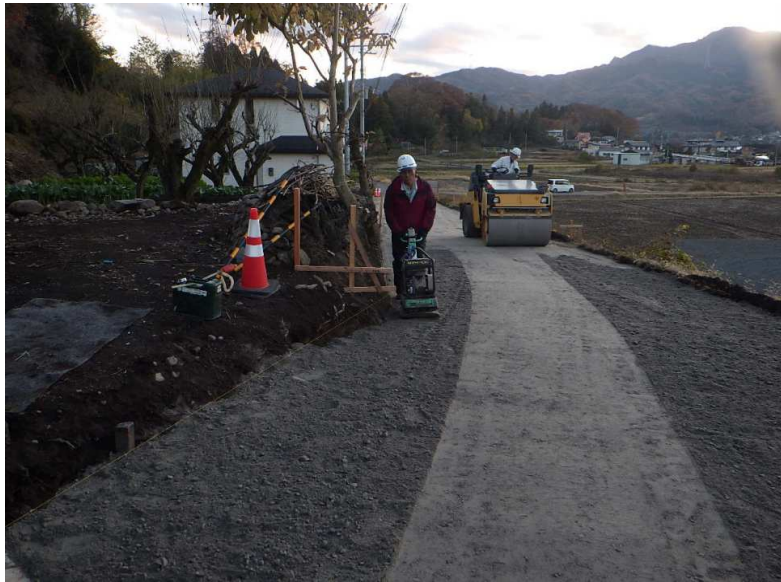
下層路盤 転圧
